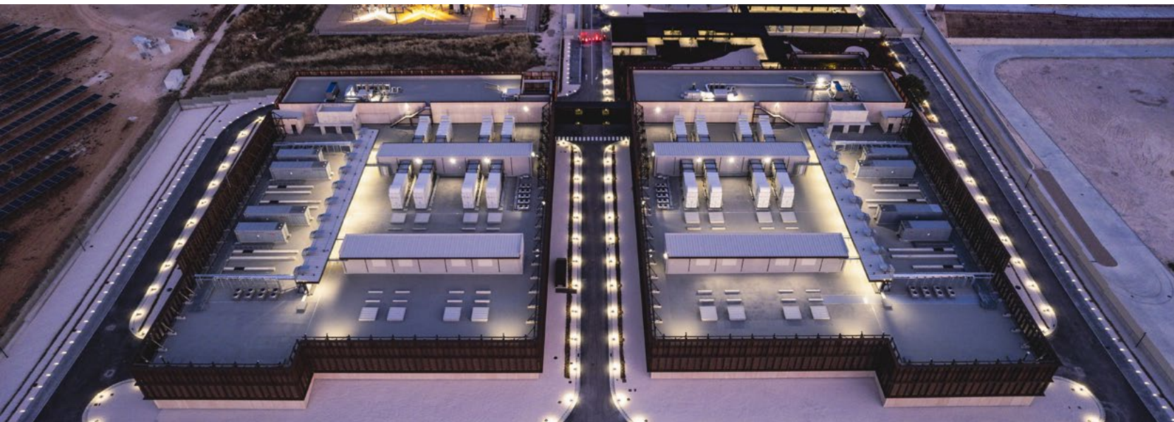
Centro de Procesamiento de Datos, ejecutado por FCC Industrial, en Torija (Guadalajara).
